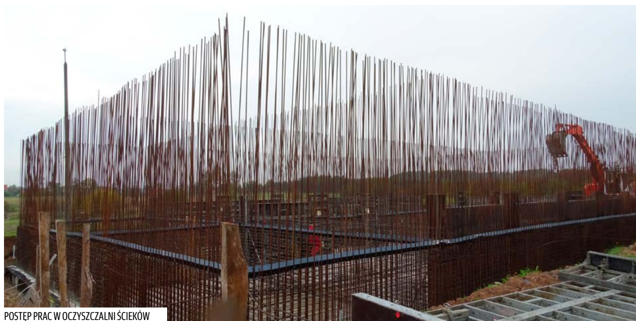
POSTĘP PRAC W OCZYSZCZALNI ŚCIEKÓW
