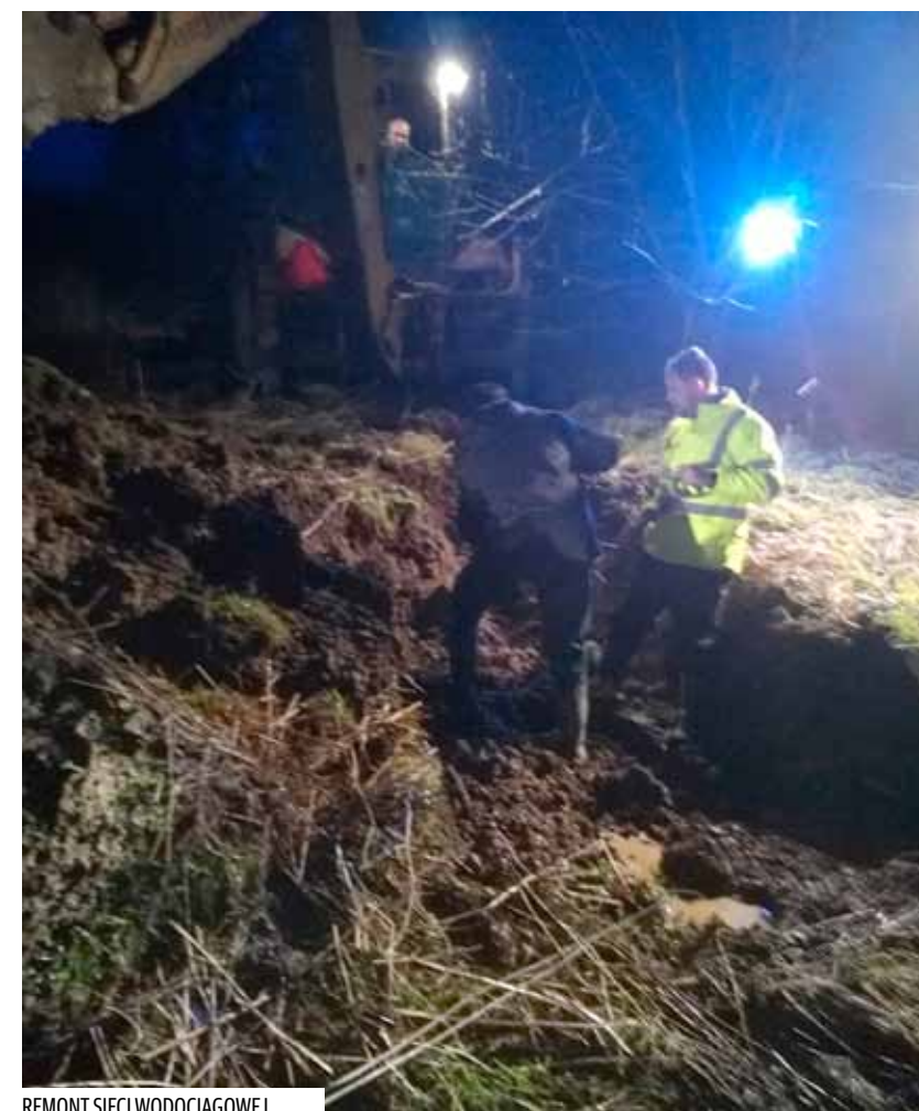
REMONT SIECI WODOCIĄGOWEJ
